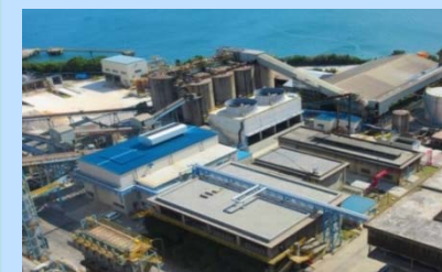
排熱発電設備
